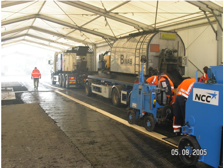
Exempel på den omfattande maskinpark som erfordras vid läggning av slitlager av gjutasfalt med invältad BCS-sten. Bild från Kvicksundsbron.
