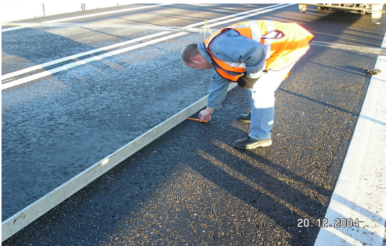
Jämnhetsmätning utförs med rätskiva på öppningsbar bro i Köpmannebro.
