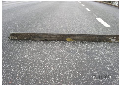
Vasselhyttan norrgående fil med BPGJA 11 med BCS 6-8 mm
