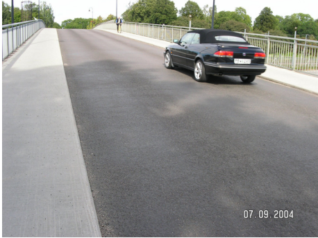
Viadukt över järnvägen vid järnverket i Sandviken
